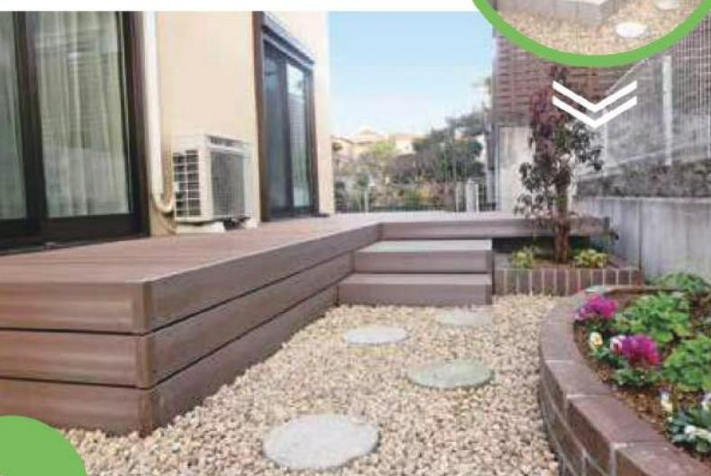
リビングから庭に降りる土間が石とタイルで、真夏は熱くて素足で歩けない、というお悩みを、ローメンテナンスな樹脂製ウッドデッキで解消。既存の土間を壊さず、コストダウンも図りました。
